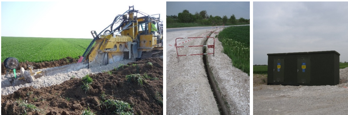
Illustration d'une trancheuse en action, d'une tranchée et d'un poste de livraison (Source : TotalEnergies).
