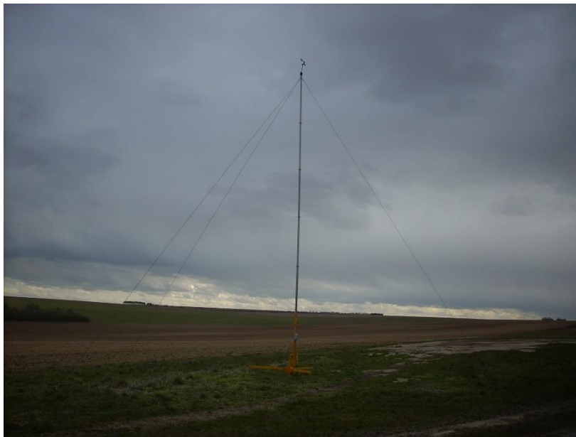
Photo du mât météo positionné sur site
