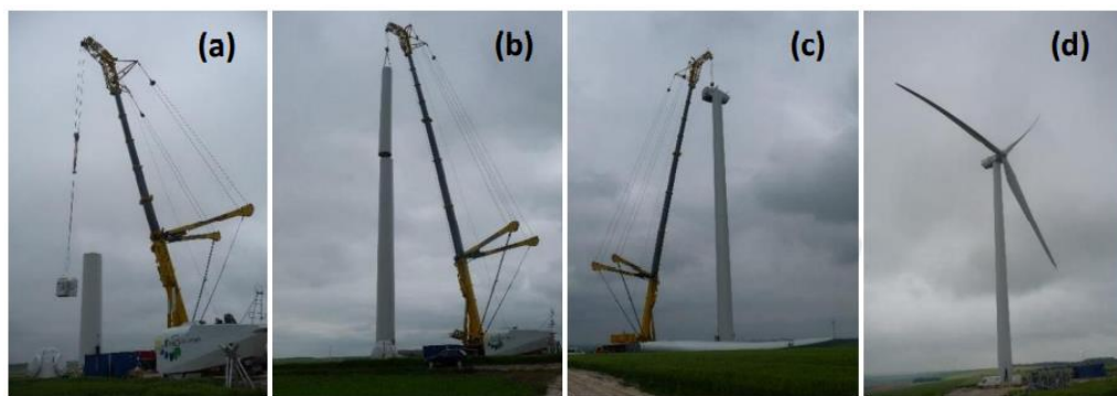
Figure 7 : photographie de l'installation des éoliennes
