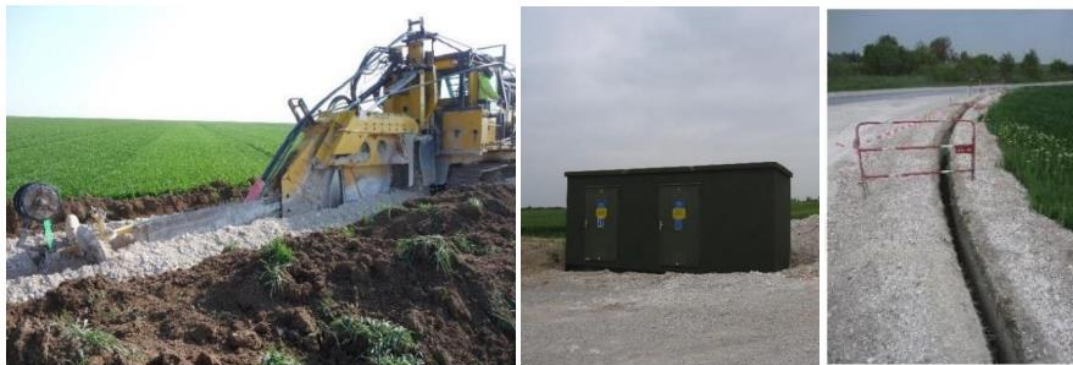
Figure 8 : photographie de l'installation du raccordement électrique
