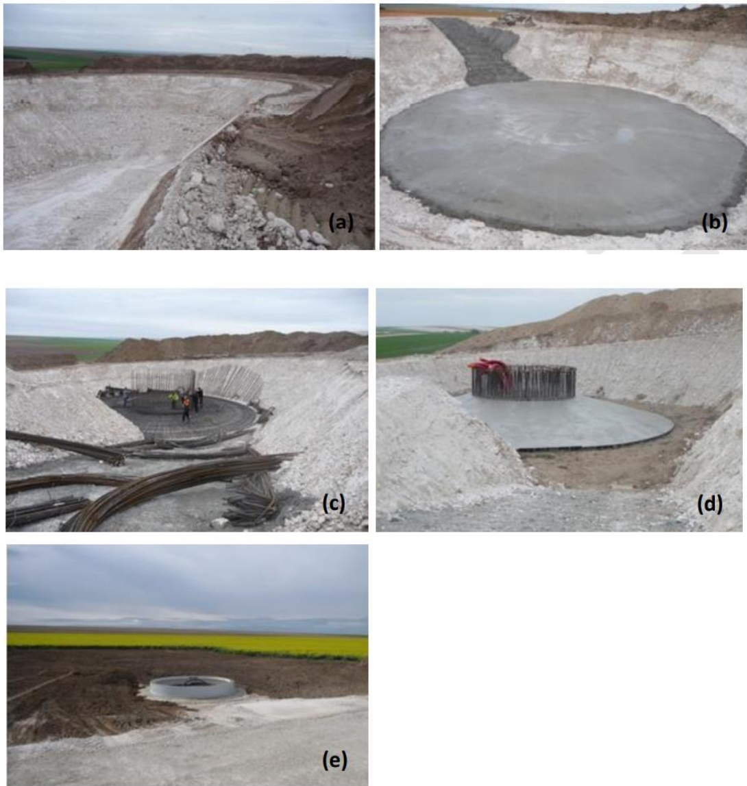
Figure 5 : photographie de l'installation des fondations
