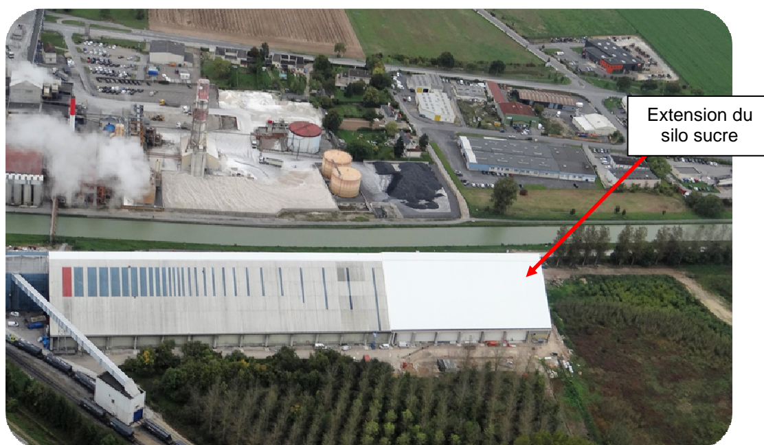
EXTENSION DU SILO SUCRE
