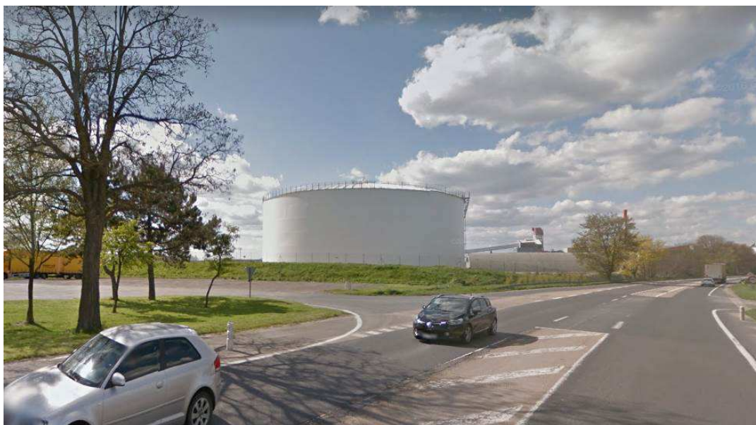
CUVE DE SUBSTRATS SUCRES DE 45.000 M 3
