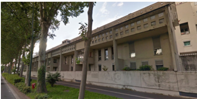
Immeuble HLM (300 logements), boulevard Paul Doumer, Paul Chemetov et Gérard Liucci assistant. SA d'HLM l'Effort Rémois, maître d'ouvrage. Source : Google Maps
