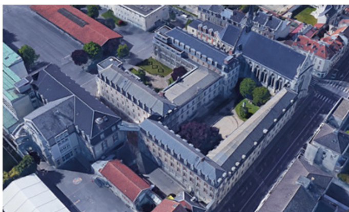
Vue du collège Saint-Joseph édifié après 1866 (la chapelle en 1876). Source : Google Maps
