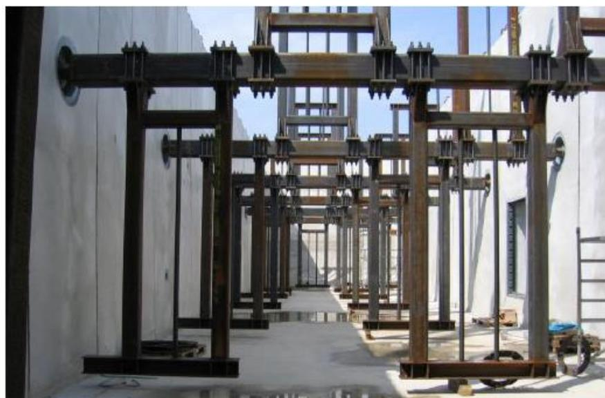
**Figure 6 : Exemple de digesteur sec LARAN® (source Strabag)**
