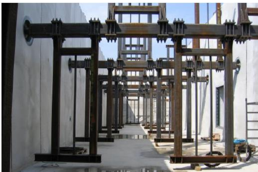
Figure 6 : Système d'agitation de type STRABAG.
