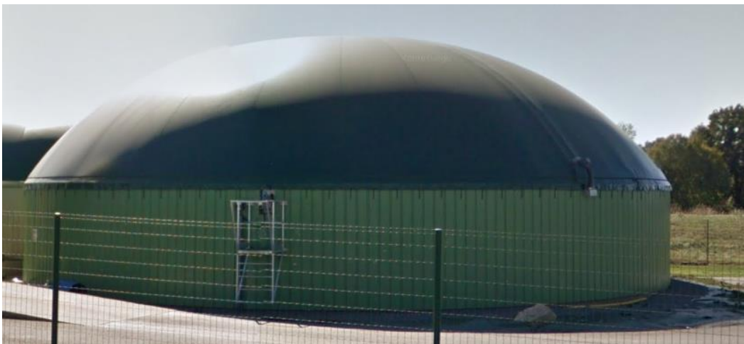
Figure 8 : Exemple de post-digesteur (site Agri-Bio-Méthane - 85)
