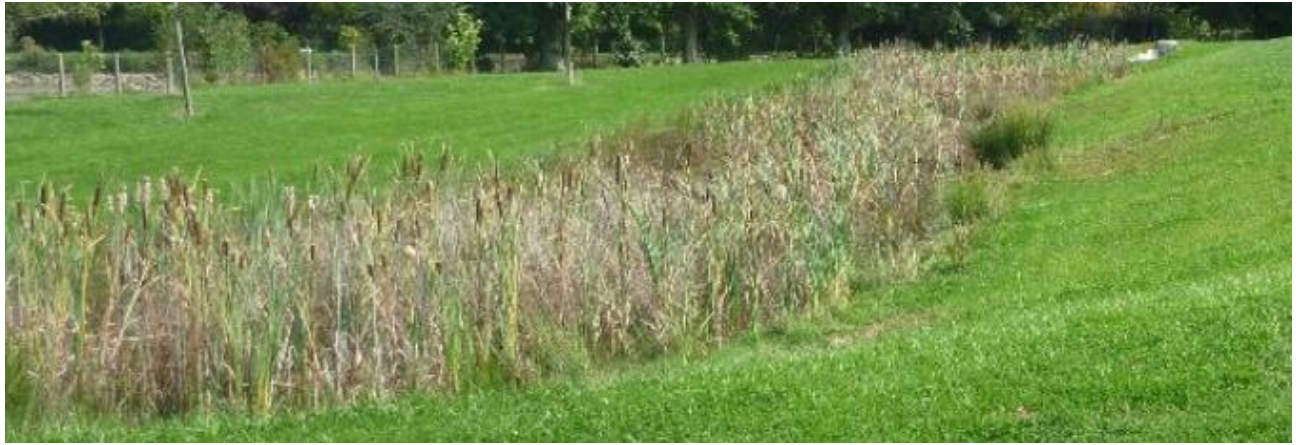
Figure 35 : Exemple de bassin végétalisé
