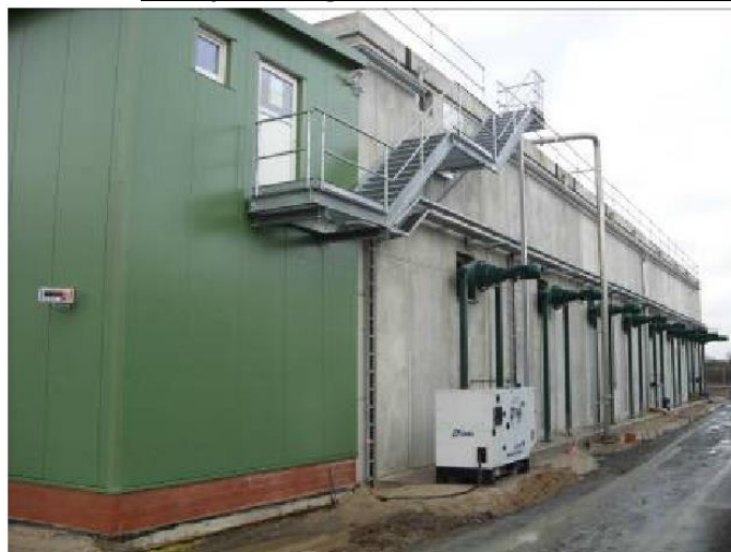
Figure 7 : Exemple de digesteur sec LARAN® (source Strabag)
