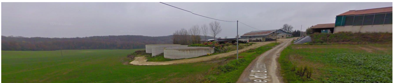
Figure 27 : Vue sur le stockage externe existant depuis le chemin rural
