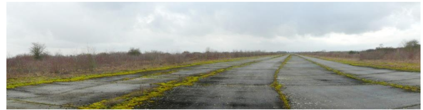
Figure 5 : Photographie de la piste Sud (taxiway) – Parc B
