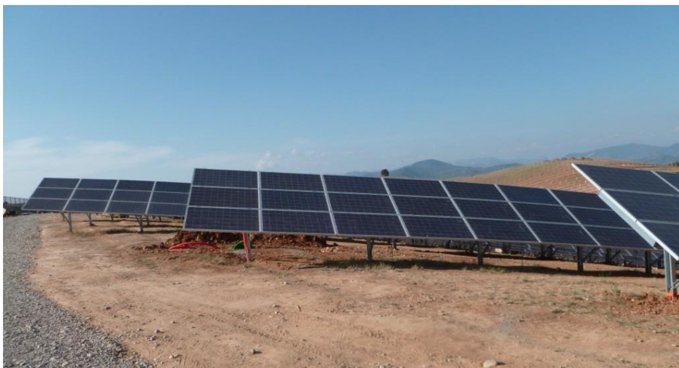
Figure 12 : Exemple de tables d'assemblage
