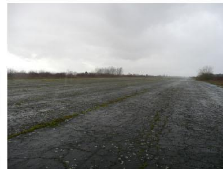
Vue actuelle depuis l'intérieur de la centrale à l'Ouest du parc A (VUE S2)
