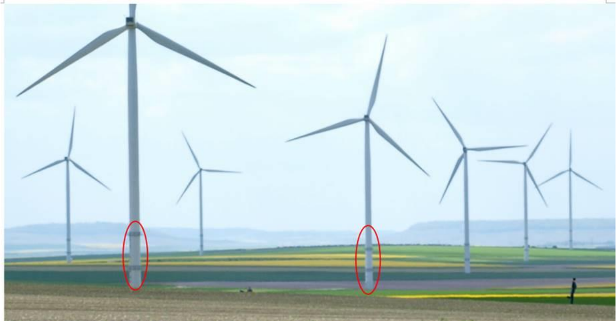
Eoliennes du parc de Germinon
