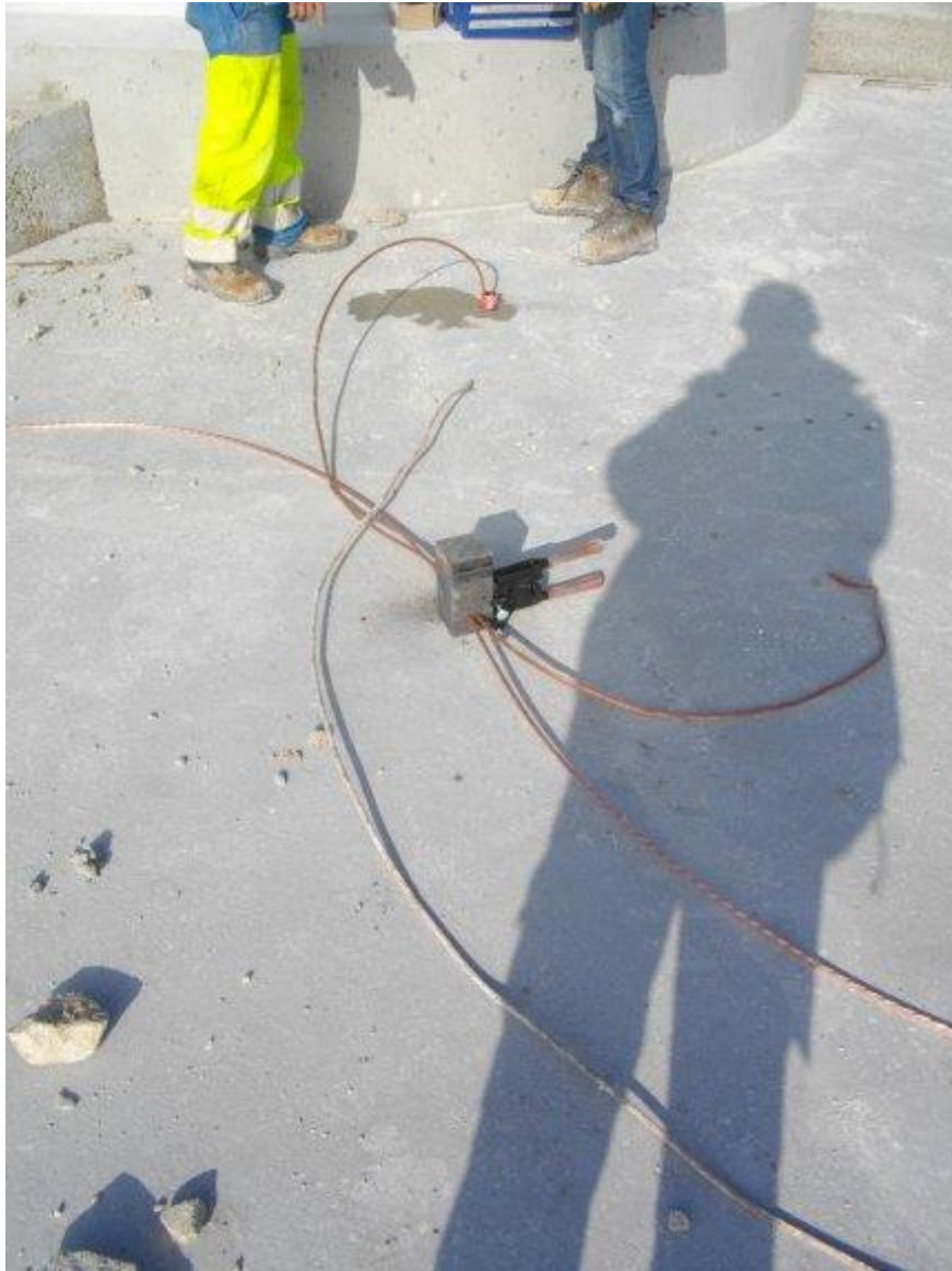
Figure 5 - interconnexion du réseau de terre
