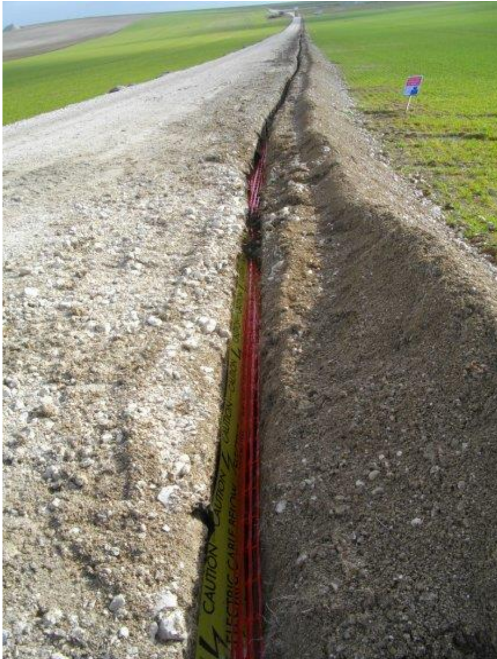
Figure 2 - Tranchée avant remblayage (Câbles et grillage posés)
